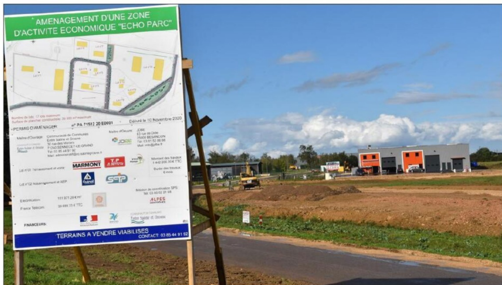
La zone Écho parc à Sennecey-le-Grand, en cours d'aménagement, et celle de Cormatin seront les deux seules autorisées dans le futur document d'urbanisme.. Photo JSL/Florent MULLER
