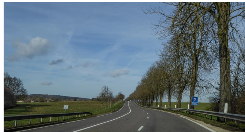
Rupture des continuités écologiques liée au passage de grandes infrastructures terrestres [D 906].
